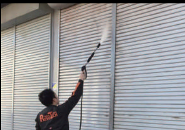
工場や倉庫のシャッター洗浄
