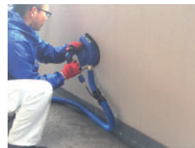
ハンドツールとして壁面洗浄
